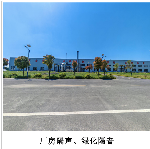
图 4.3 本次验收项目噪声治理设施
