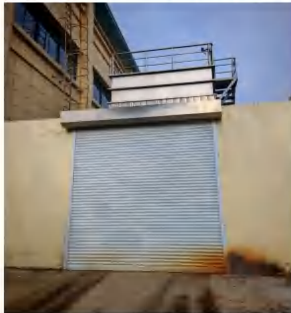
一般固废暂存场所
