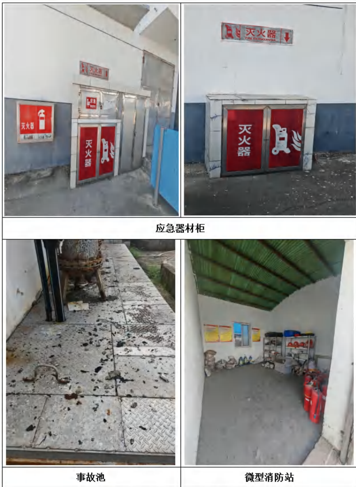
图 4.5 本次验收项目环境风险防范设施
