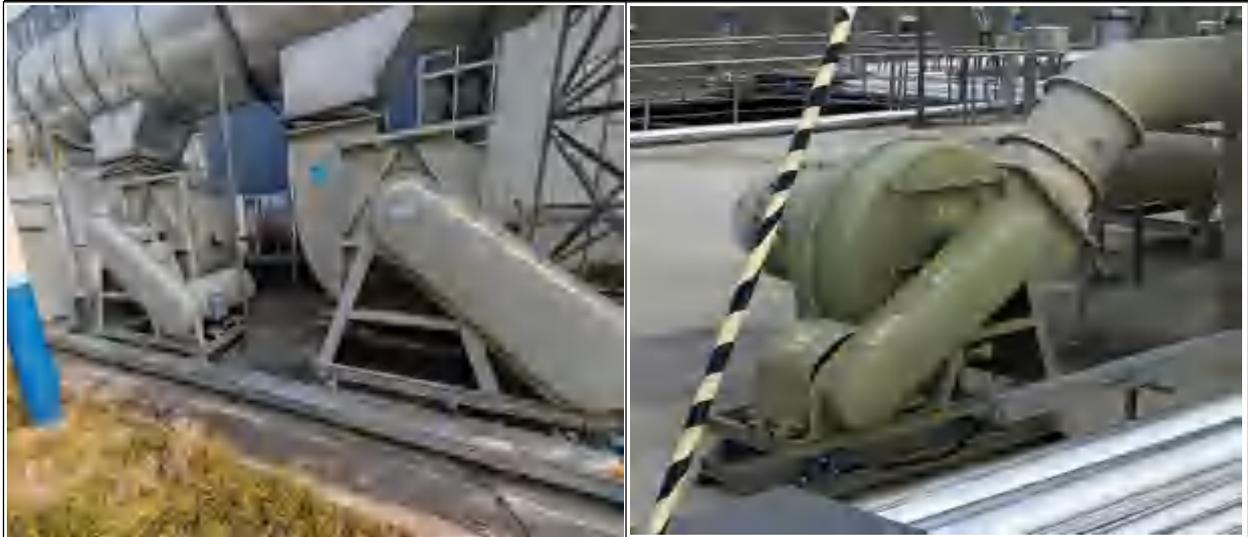
基础固定减震、加装隔声罩
