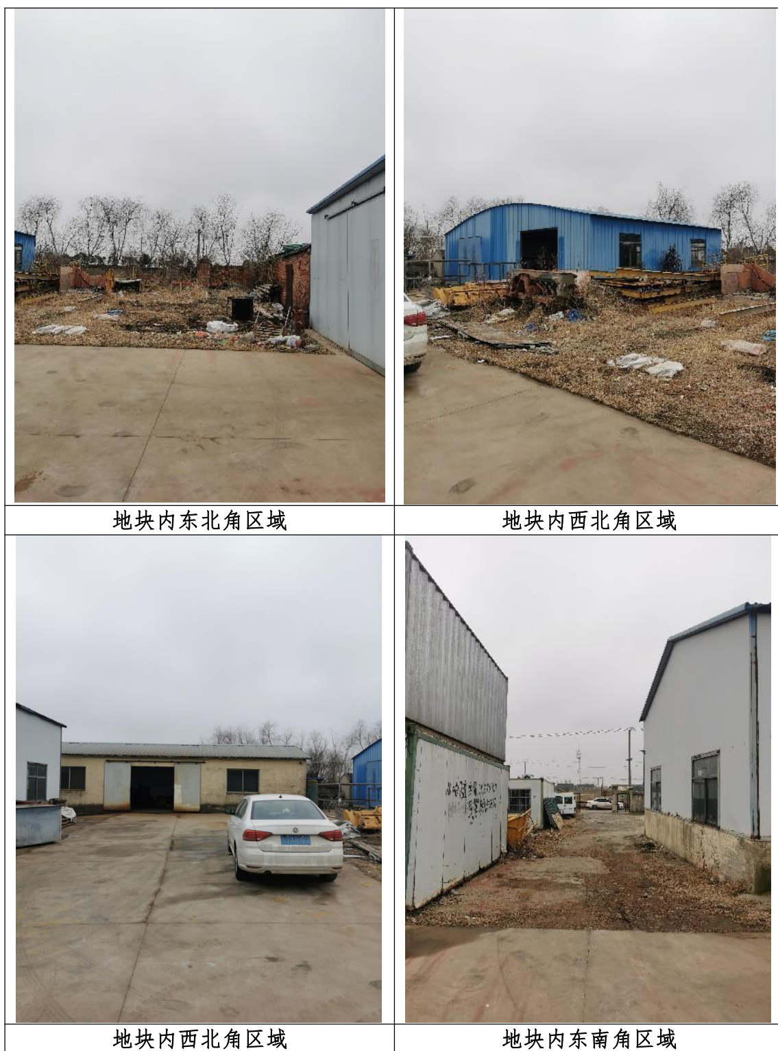
图 2.3-1 调查地块现场踏勘情况图
